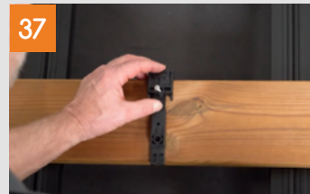
Montaggio dell'ultimo listone
