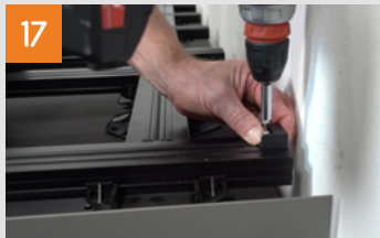
Montaggio del primo listone
