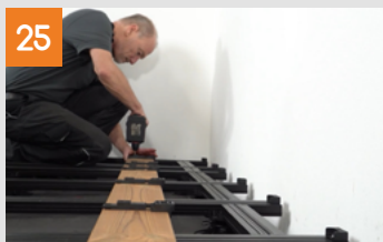
Montaggio del primo listone
