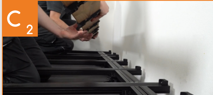
Montaggio del primo listone
