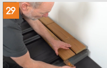
Montaggio dei listoni sulla superficie
