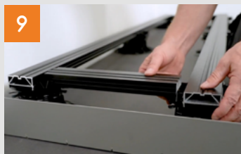
Vorkonfektionierte Streben für Queraussteifung einsetzen
