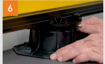
Schienen auf Terrassenlager klicken und ausrichten
