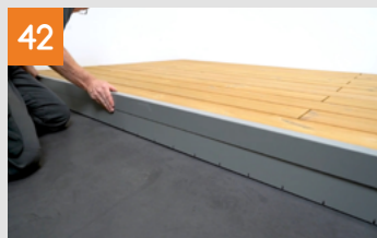
Completamento del pannello laterale
