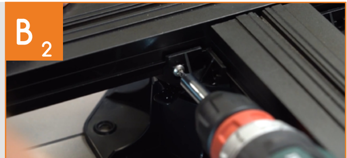
Unterkonstruktion ausrichten und mit Lagern verschrauben
