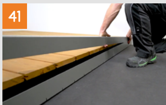
Finition des parements latéraux
