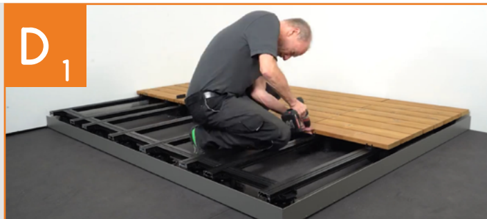
Montaggio dei listoni sulla superficie
