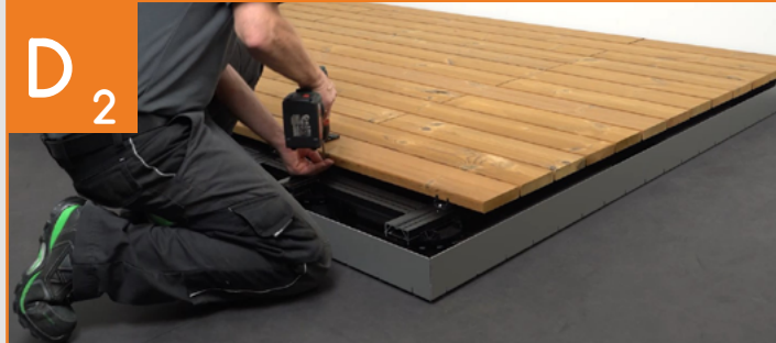
Montaggio dei listoni sulla superficie
