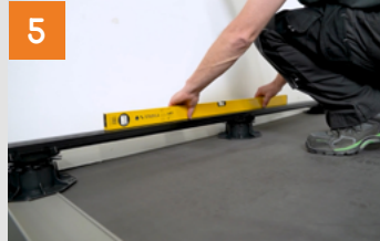
Schienen auf Terrassenlager klicken und ausrichten
