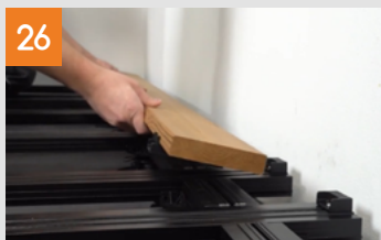
Montaggio del primo listone
