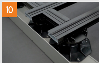
Vorkonfektionierte Streben für Queraussteifung einsetzen
