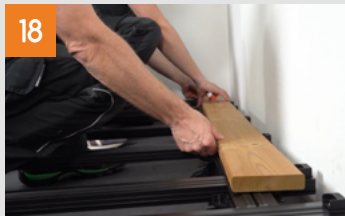
Montaggio del primo listone
