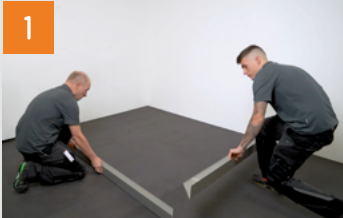
Seitenverblendung und Terrassenlager auslegen und Schienen einklicken
