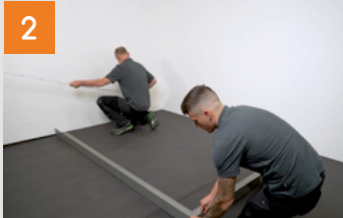
Seitenverblendung und Terrassenlager auslegen und Schienen einklicken
