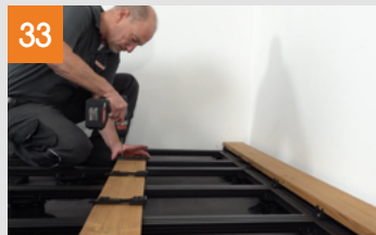
Montaggio dei listoni sulla superficie
