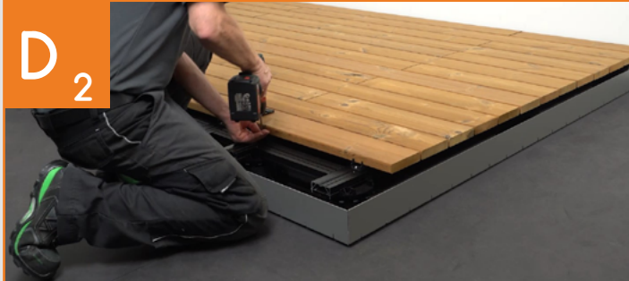
Installation des lames en surface
