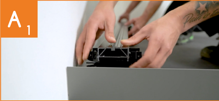
Seitenverblendung und Terrassenlager auslegen und Schienen einklicken
