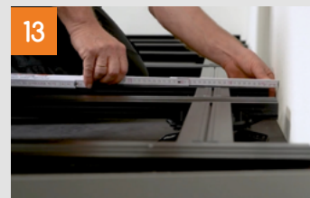
Unterkonstruktion ausrichten und mit Lagern verschrauben
