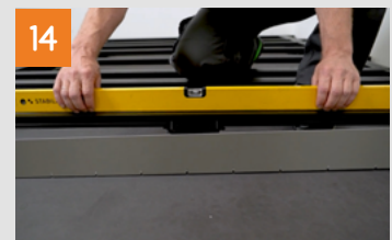
Unterkonstruktion ausrichten und mit Lagern verschrauben
