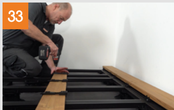
Installation des lames en surface
