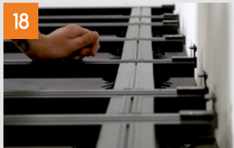
Montaggio del primo listone
