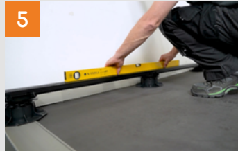
Schienen auf Terrassenlager klicken und ausrichten
