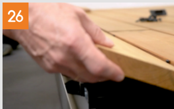
Montaggio dell'ultimo listone
