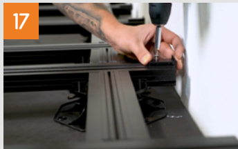
Montaggio del primo listone
