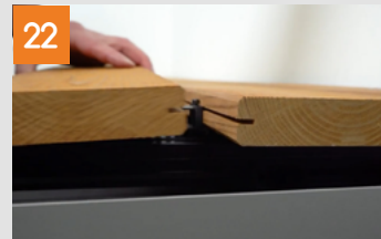
Pose des lames en surface
