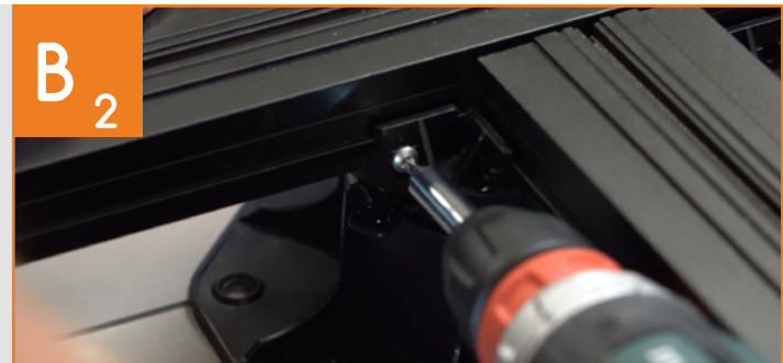
Unterkonstruktion ausrichten und mit Lagern verschrauben
