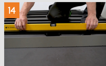
Unterkonstruktion ausrichten und mit Lagern verschrauben
