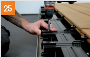
Montaggio dell'ultimo listone
