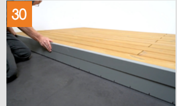
Fertigstellung der Seitenverblendung
