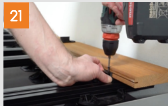
Pose des lames en surface
