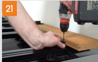
Verlegung der Dielen in der Fläche
