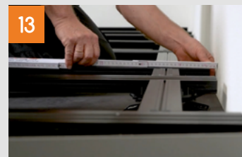
Unterkonstruktion ausrichten und mit Lagern verschrauben
