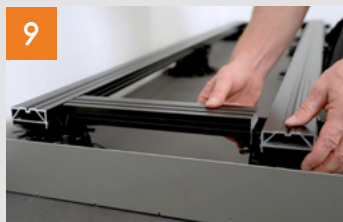
Vorkonfektionierte Streben für Queraussteifung einsetzen
