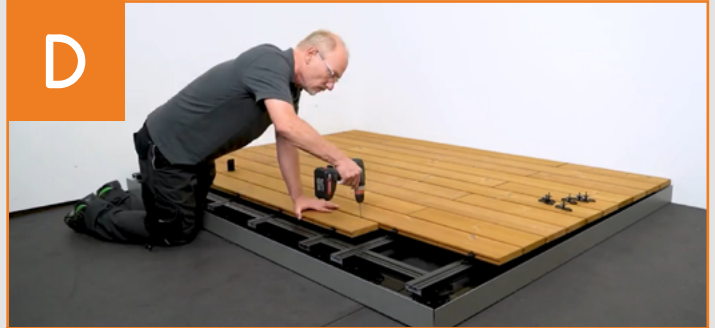
Verlegung der Dielen in der Fläche
