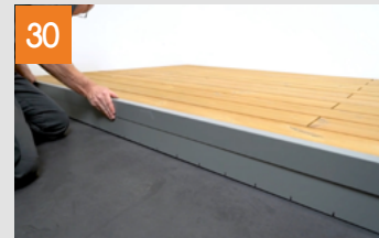
Finition des parements latéraux
