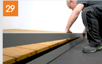
Fertigstellung der Seitenverblendung
