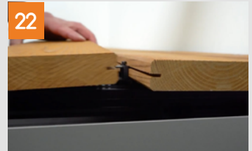
Verlegung der Dielen in der Fläche
