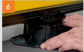
Schienen auf Terrassenlager klicken und ausrichten
