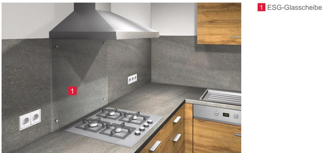
Abbildung 16: Küchensituation mit Gas-Kochfeld und Nischenrückwand mit ESG-Glasscheibe
