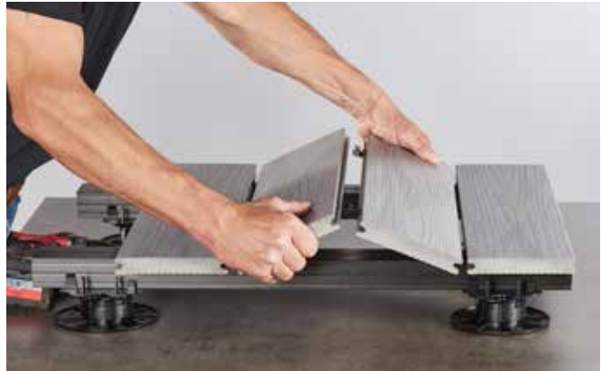
1. Montageklammern seitlich aufstecken
