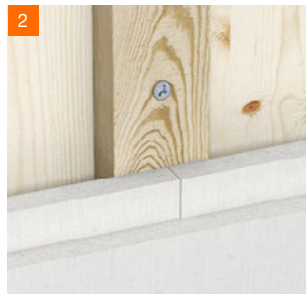
2 Holz-Unterkonstruktion vertikal oder horizontal
